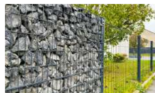
P.104 - Clôture gabion
