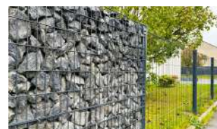
P.104 - Clôture gabion
