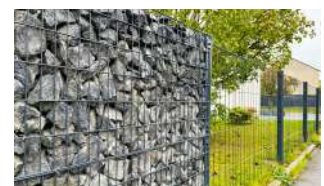
P.104 - Clôture gabion
